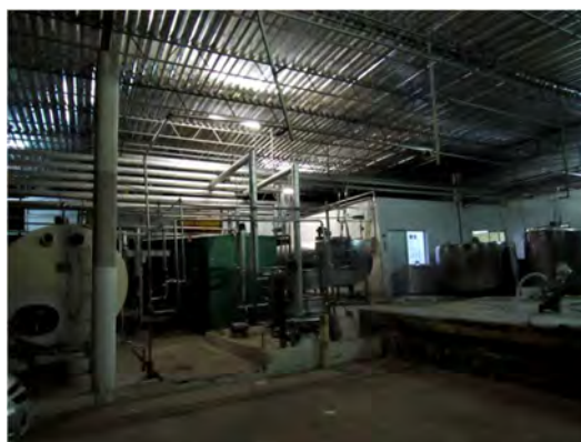
Estrutura da APASA em Angicos
