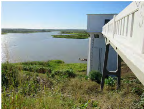
Açude Itans com nível ainda muito baixo
